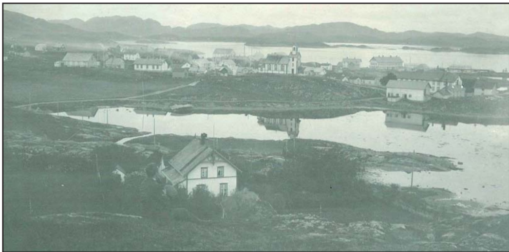
Huset i forgrunnen er Nærøysund Telegrafstation som åpnet 14.12.1876. Byggearbeidet startet i juni samme året, og huset kostet vel 11.000,- kr. I tillegg ble det bygd telegraflinje fra Namsos til Rørvik, og den kostet vel 64.000,- så den totale investeringa var betydelig. Bildet er tatt ca 1920. Televerket/Telenor har siden 1876 vært til stede her, og i dag er Telenor-Mobil en av de største arbeidsplassene i kommunen.
